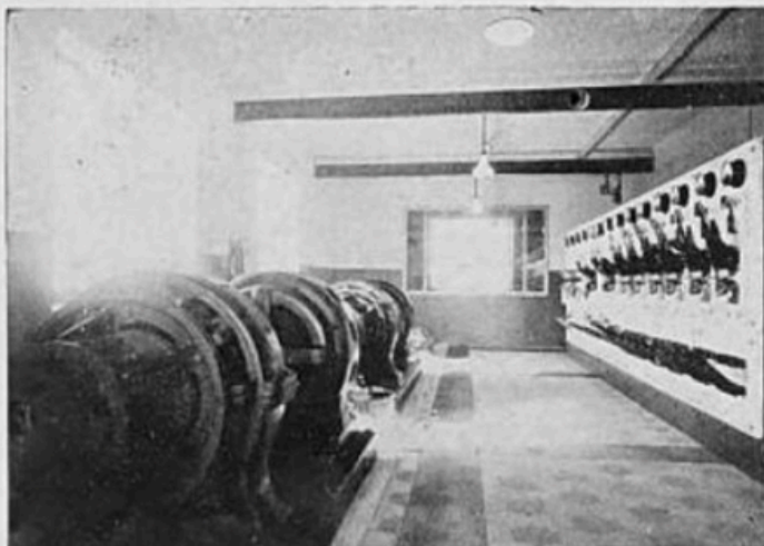
Gli impianti elettrici.
