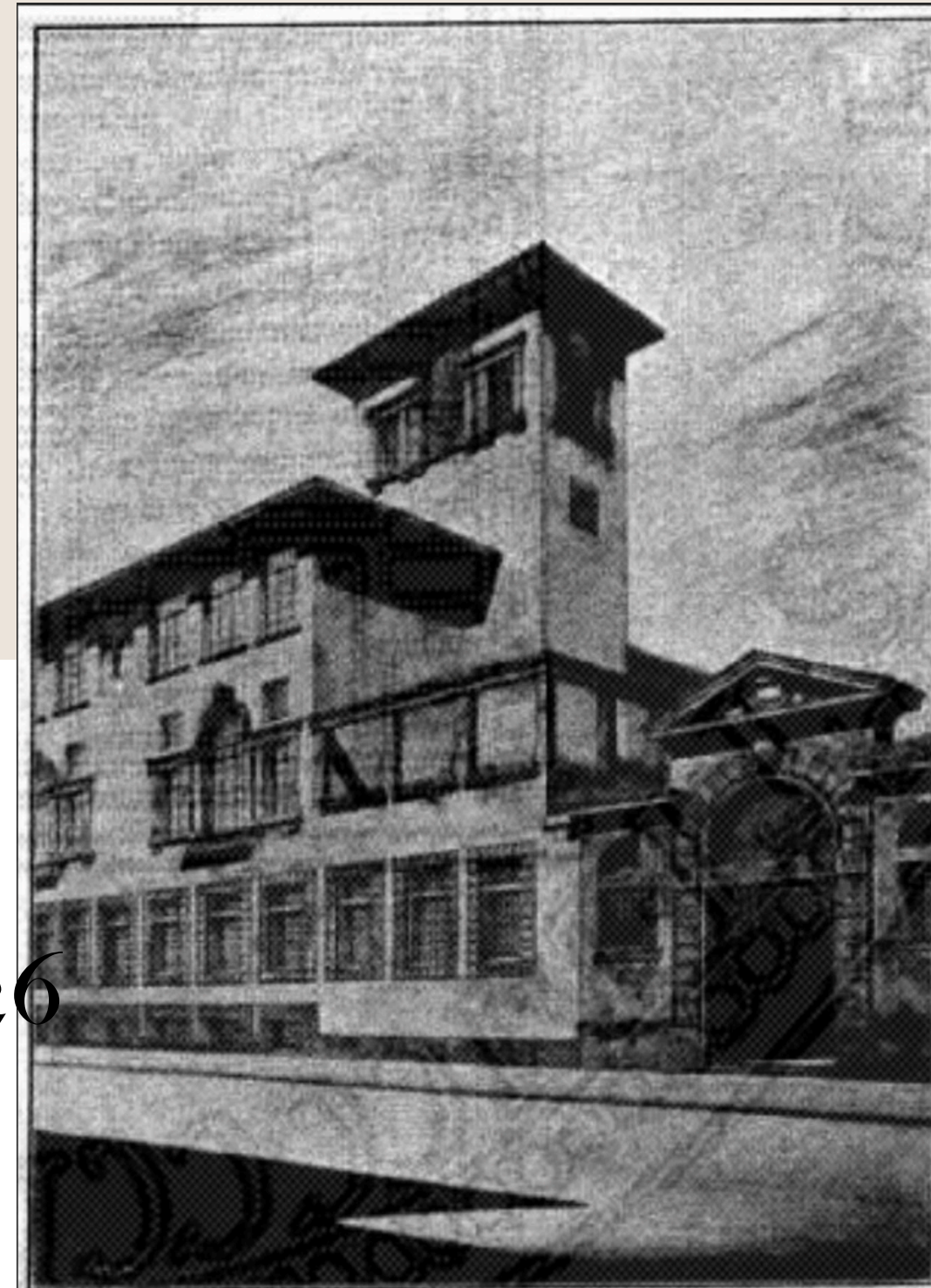
ARCH. V. FASOLO - PARTICOLARE DELLA SCUOLA DI VIA MONDOVI
